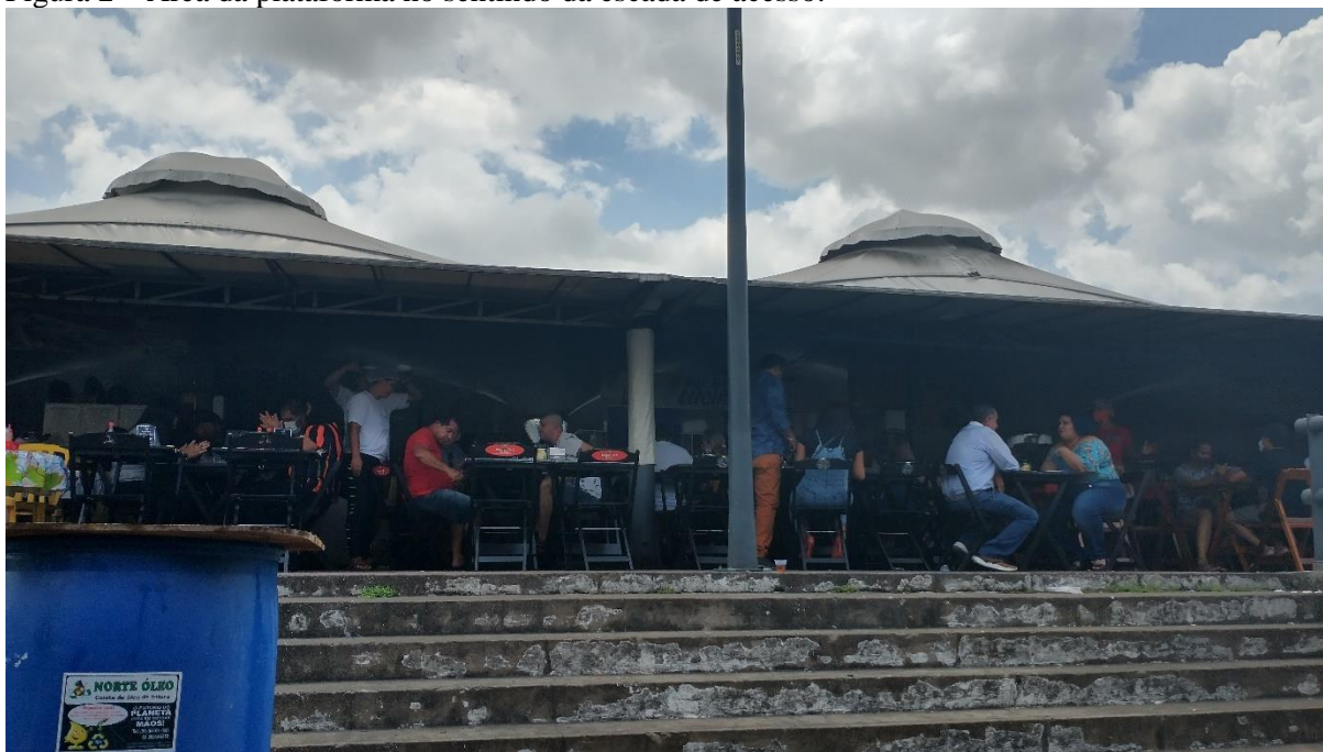
Figura 2 – Área da plataforma no sentido da escada de acesso.
